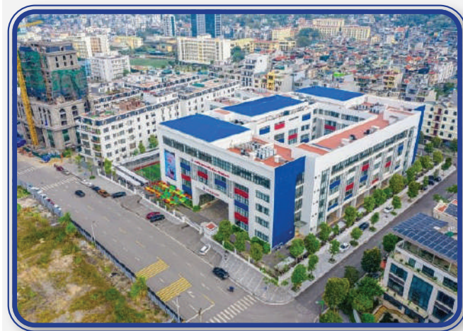
Dự án trường Liên cấp Vinschool Hạ Long (Quảng Ninh) Vinschool Hạ Long Inter-level School Project (Quang Ninh)
