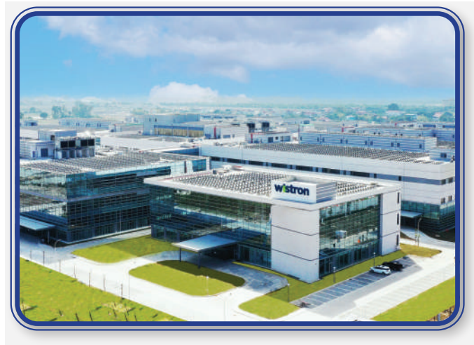
Dự án Nhà máy Wistron Hà Nam (Ninh Bình)
