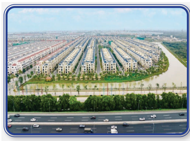
Dự án Vinhomes Dream City (Ocean Park 2, Hưng Yên)
