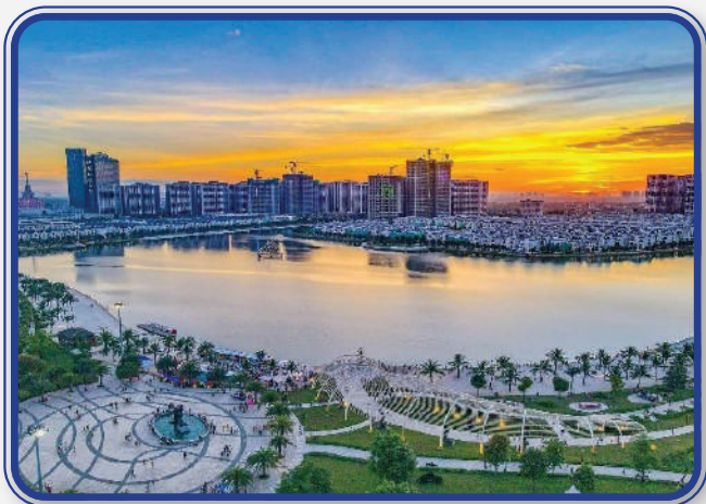
Dự án Vinhomes Ocean Park (Gia Lâm, Hà Nội) Vinhomes Ocean Park (Gia Lam, Ha Noi)
